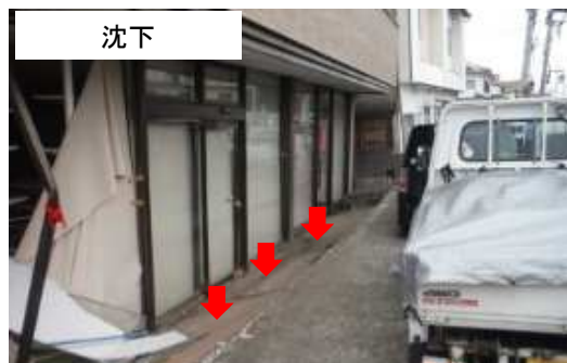
家屋の沈下(道路との段差)
