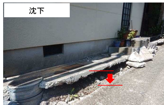
杭支持された家屋と周辺地盤の沈下差によるライフラインの破損
