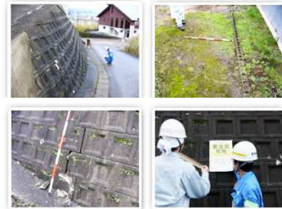
(左上)擁壁の被害状況調査(右上)宅地の被害状況調査 (左下)亀裂幅や傾斜の調査(右下)調査結果の掲示
