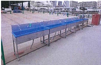
現場の手洗い場所の増設
