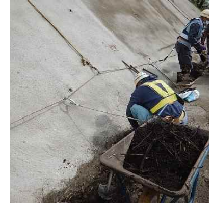
作業時なるべく離隔を確保
